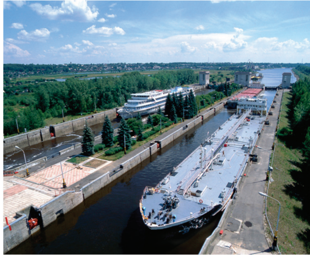
Рис. 1. Городецкий двухниточный шлюз
