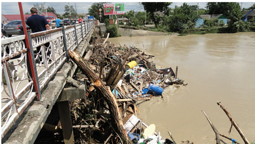
Рис. 4 Естественная плотина, образовавшаяся под автомобильным мостом у г. Крымска
