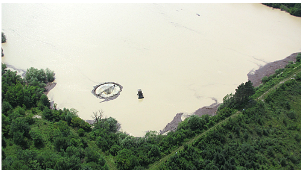
Рис. 3 Шахтный водослив Неберджаевского водохранилища
