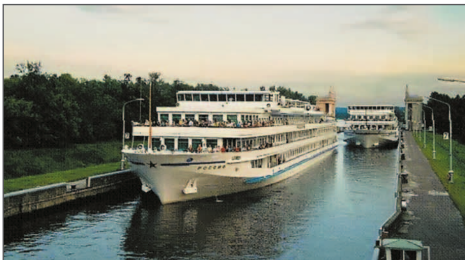
Рис. 1.8. Пассажирские теплоходы в шлюзе на канале имени Москвы
